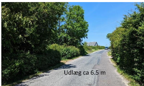
FOTO Jelshøjvej set mod nord – standpunkt ud for nr. 131
